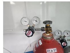
ตรวจสอบแรงดันท่อน้ำแก๊ส H2, N2
