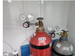
ตรวจสอบแรงดันท่อแก๊ส H 2 , N 2
